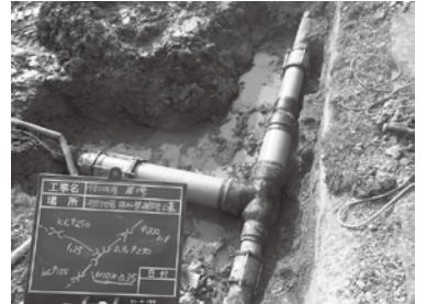
県の補助事業による用水管補修工事
