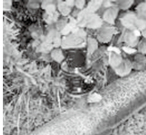
まるごと交付金による支線空気弁の更新
